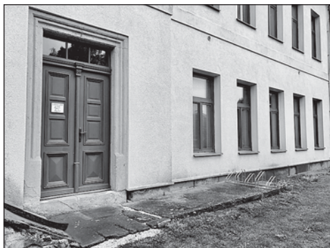
Vchod do knihovny před rekonstrukcí
