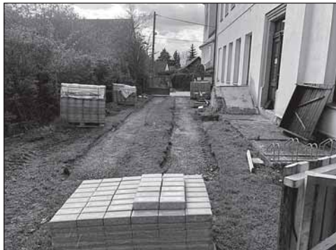
Příjezdová cesta před rekonstrukcí
