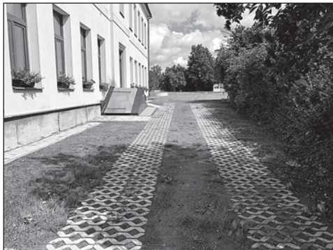
Příjezdová cesta po rekonstrukci
